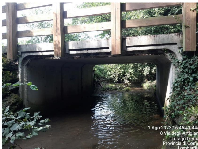
Figura 16 – Progetto Rev. 09/2023 – Scatolare prefabbricato in CLS dimensioni 4 x 2,25 x 6 m
