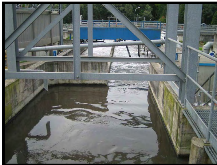
4 Dissabbiatura e disoleatura
