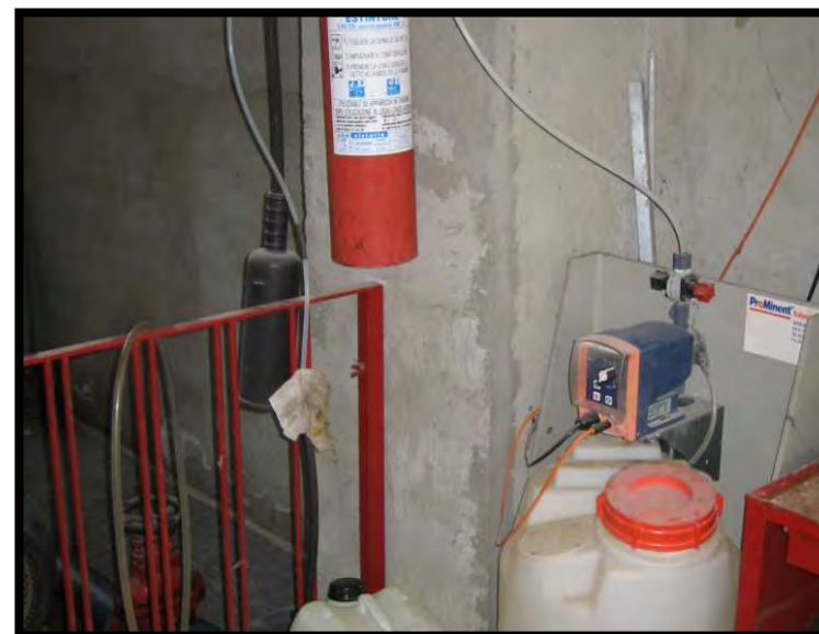
4 Sistema di disinfezione dell'acqua nella vasca di accumulo
