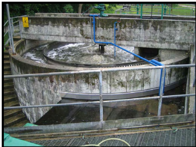
15 Dissabbiatura e disoleatura
