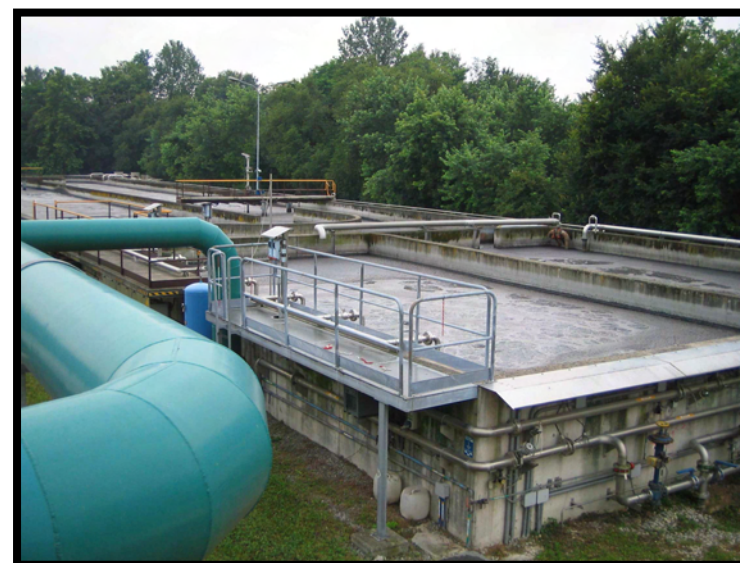
8 Ossidazione con diffusione bolle fini
