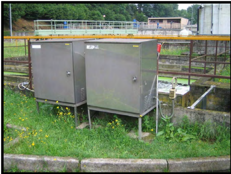
11 Campionatore automatico in uscita
