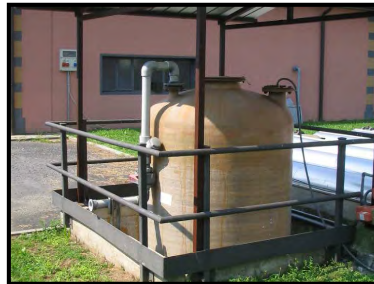
12 Serbatoio cloruro ferrico
