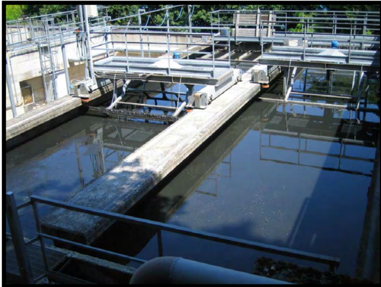
7 Sedimentazione secondaria
