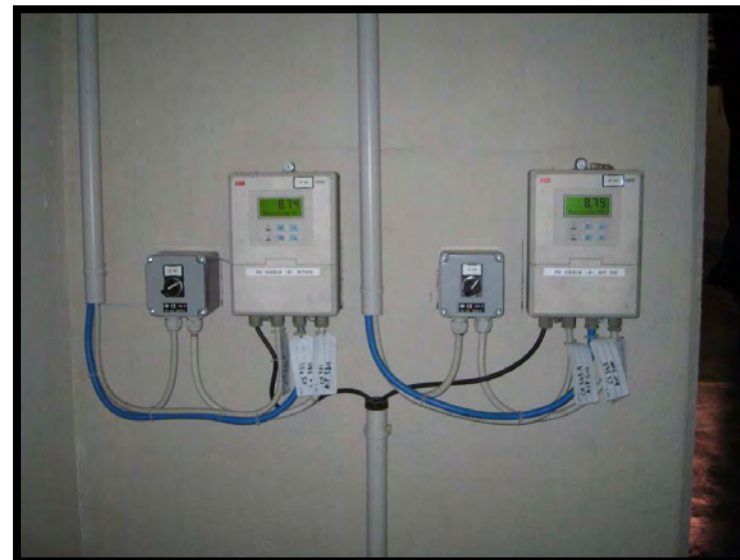
14 Sistema di controllo pH
