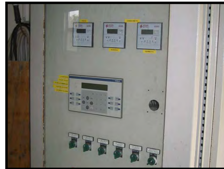
8 Sistema di telecontrollo
