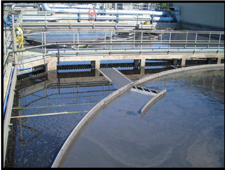
17 Sedimentazione secondaria
