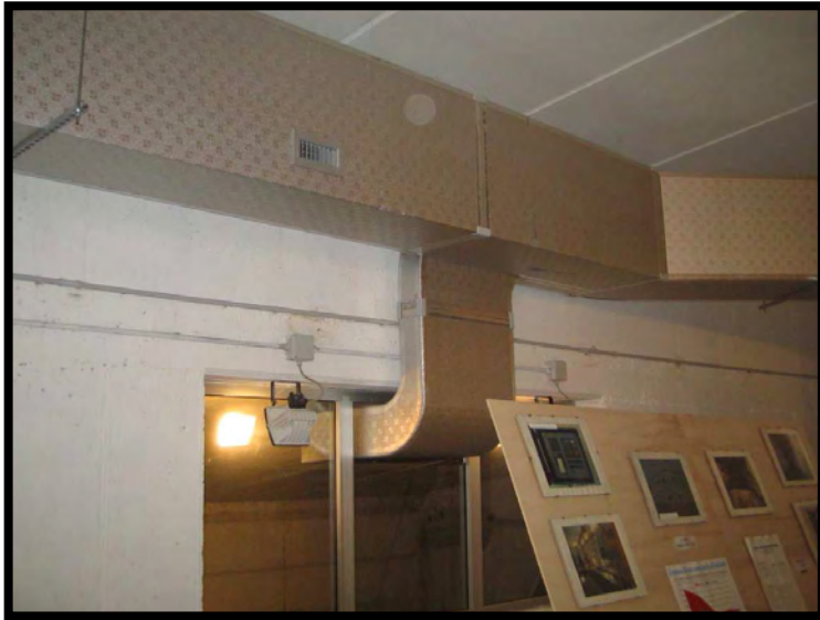
9 Sistema di deumidificazione dell'aria
