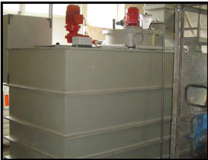
31 Preparazione polielettroliti
