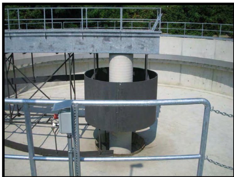
15 Sedimentazione secondaria nuova
