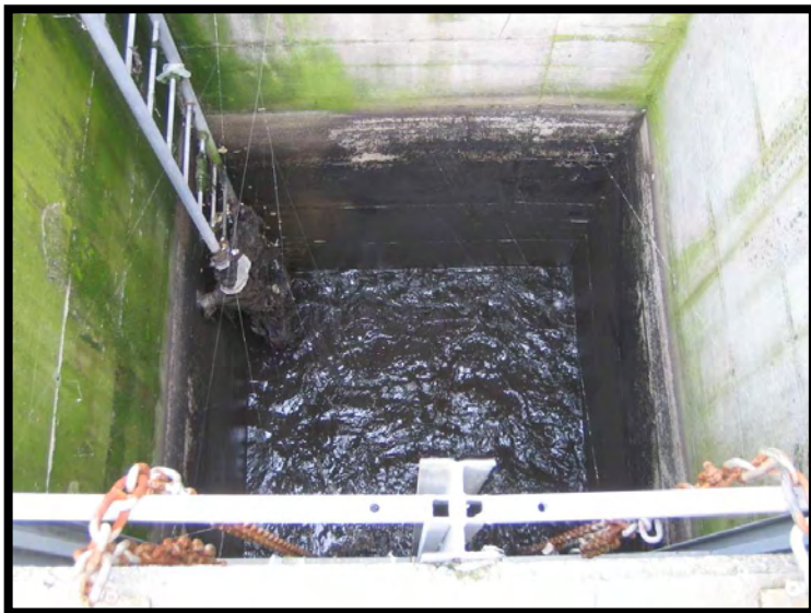
1 Arrivo reflui con grigliatura grossolana
