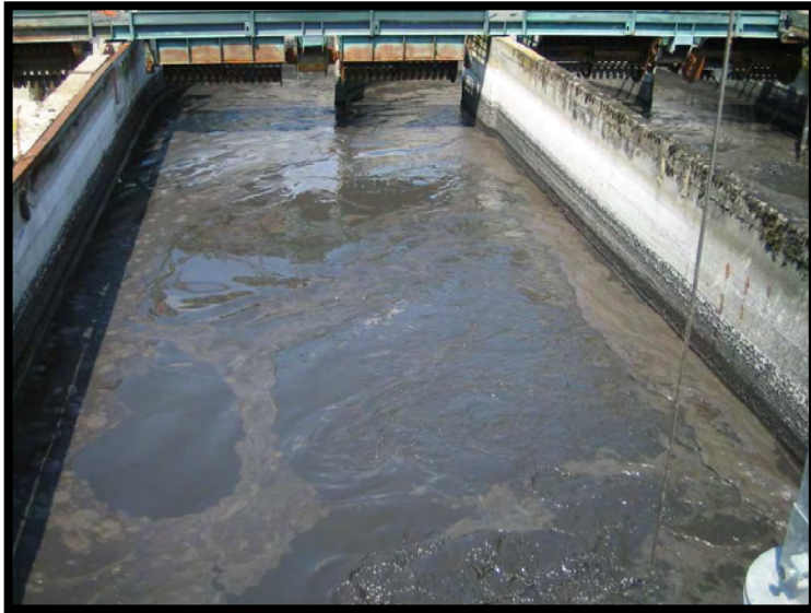
9 Digestione aerobica e ispessimento batch
