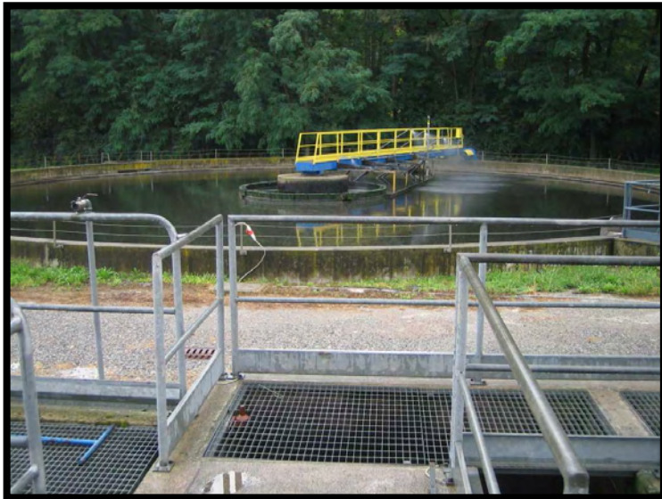
21 Sedimentazione secondaria
