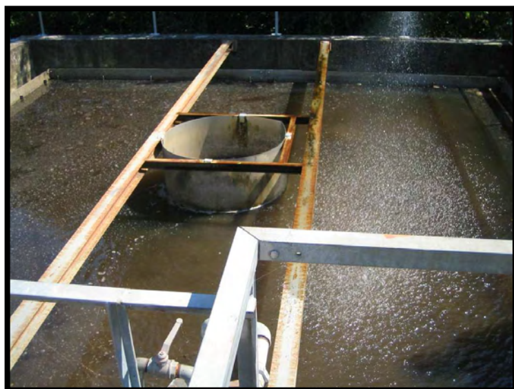
7 Sedimentazione secondaria
