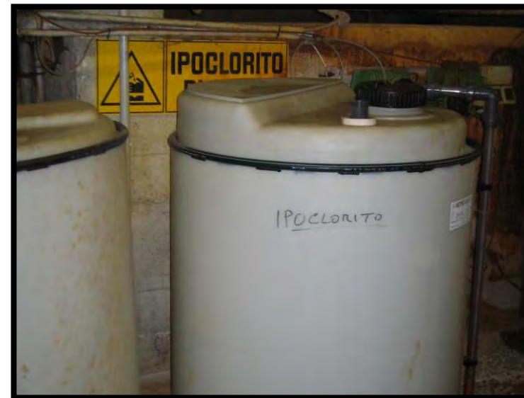
8 Serbatoio ipoclorito di sodio
