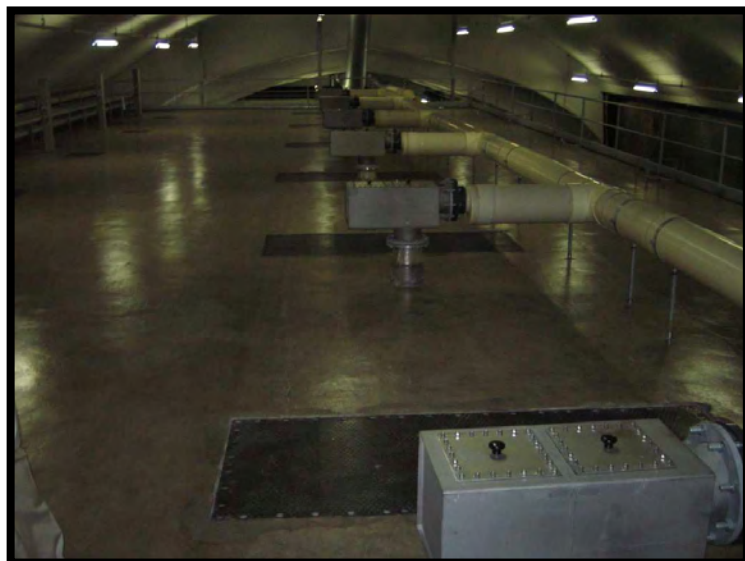
11 Filtri a carbone attivo granulare
