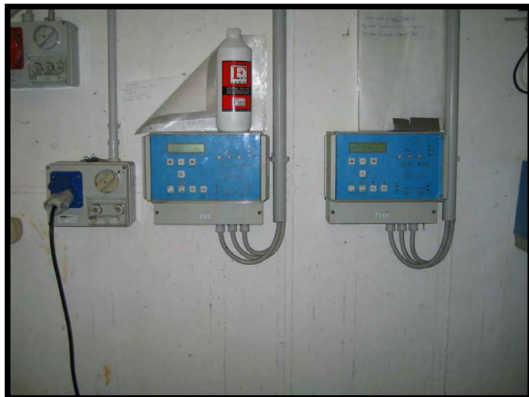
1 Centraline misura caratteristiche acqua
