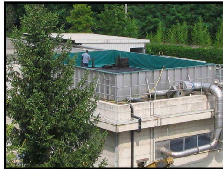
30 Biofiltro edificio trattamento fanghi
