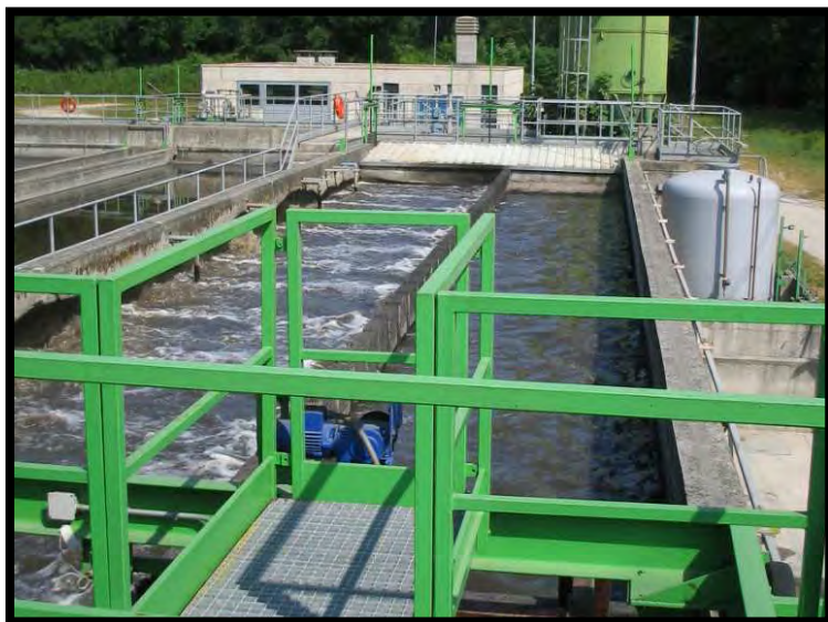
7 Dissabbiatura disoleatura
