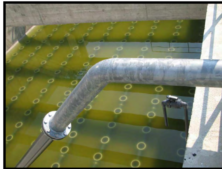
10 Ossidazione-nitrificazione nuova linea
