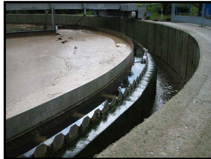
8 Dettaglio sedimentazione secondaria
