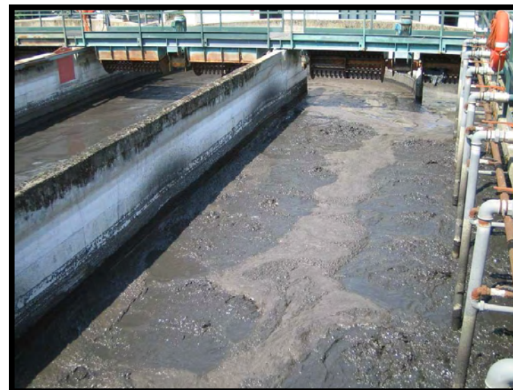
8 Digestione aerobica e ispessimento batch
