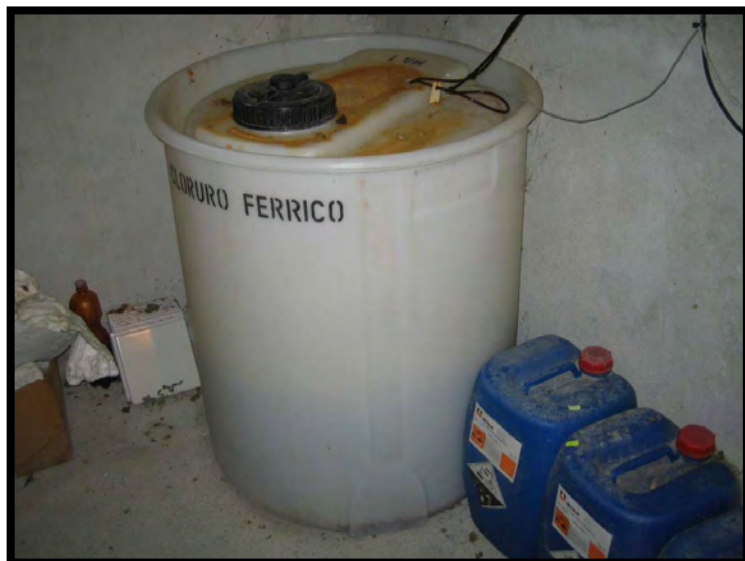
11 Serbatoio cloruro ferrico
