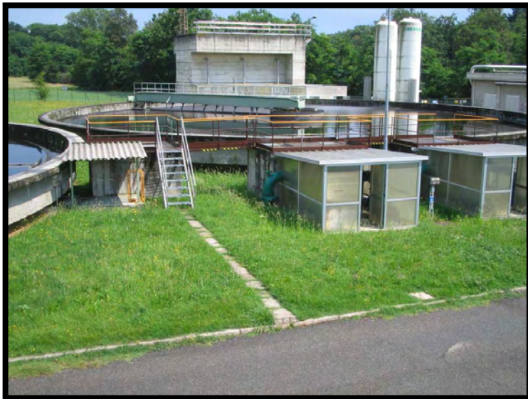
11 Sedimentazione secondaria
