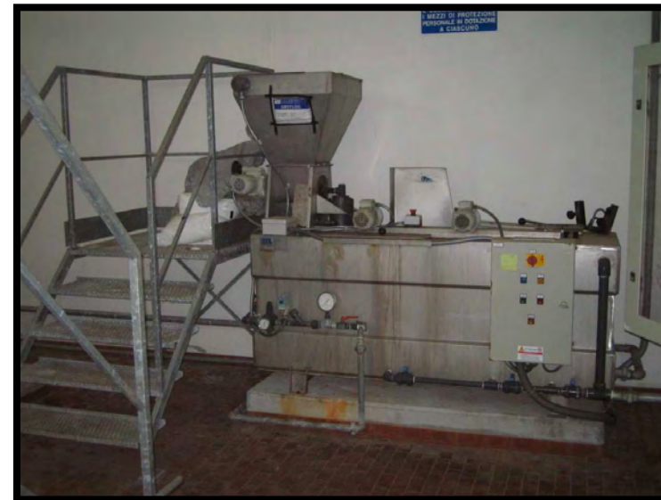
18 Preparazione polielettroliti
