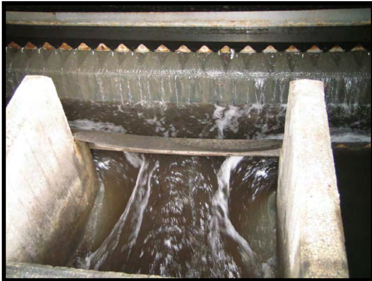
9 Sedimentazione prim. dettaglio stramazzo
