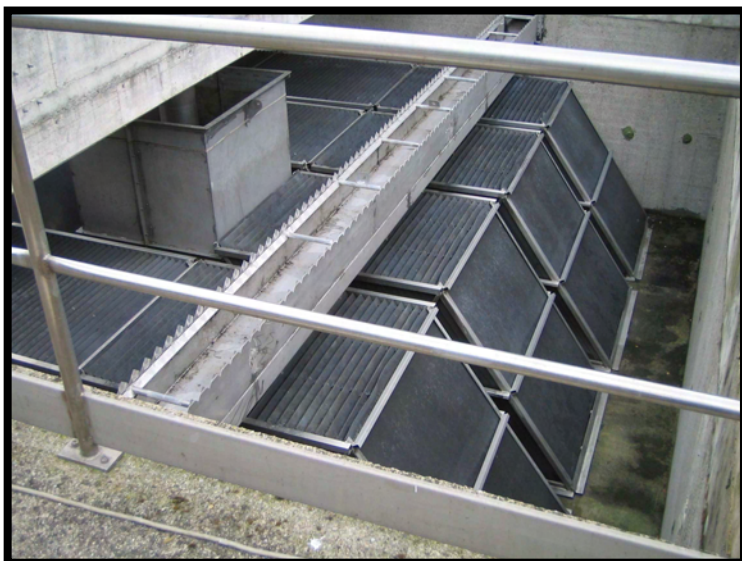
15 Chiariflocculazione dettaglio pacchi lamellari
