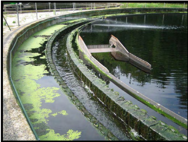
17 Dettaglio sedimentazione secondaria
