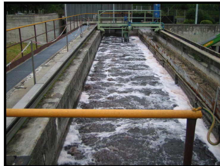
6 Dissabbiatura disoleatura
