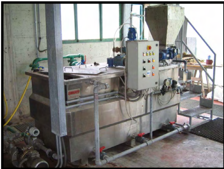
33 Preparazione polielettroliti
