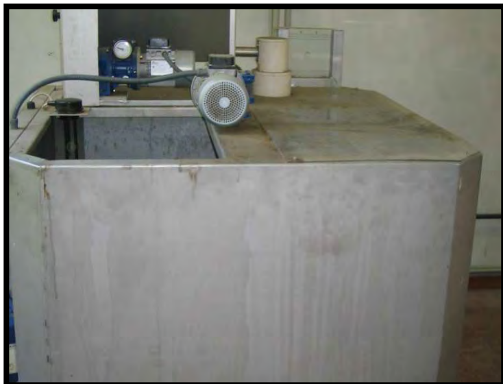
17 Preparazione polielettroliti
