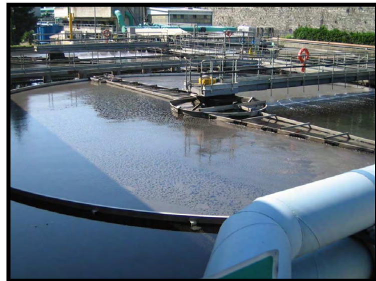
16 Sedimentazione secondaria
