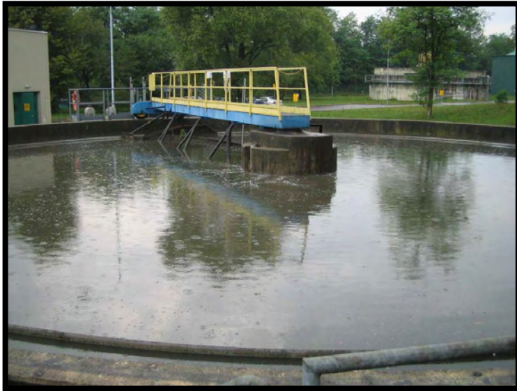
17 Sedimentazione primaria
