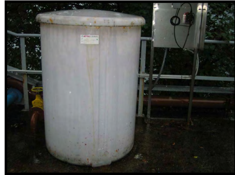
10 Serbatoio ipoclorito di sodio
