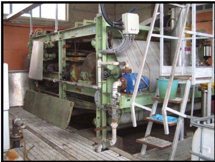
25 Nastropressa di emergenza
