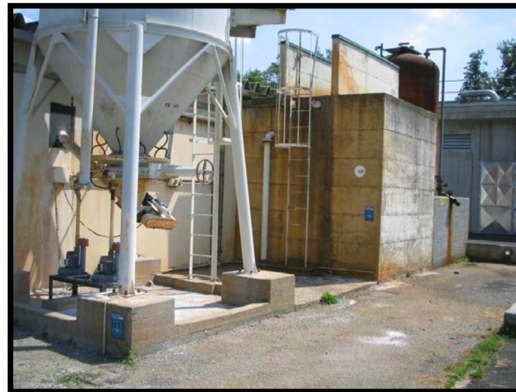
14 Silos calce e cloruro ferrico
