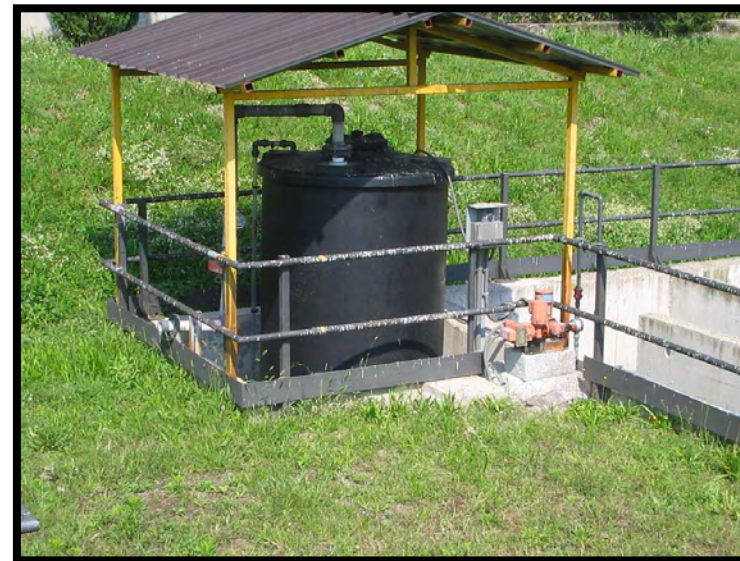
18 Serbatoio ipoclorito di sodio
