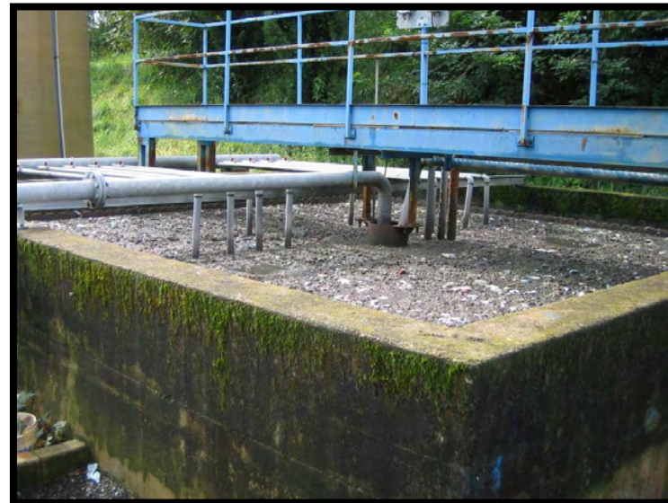
12 Digestione aerobica e ispessimento in batch
