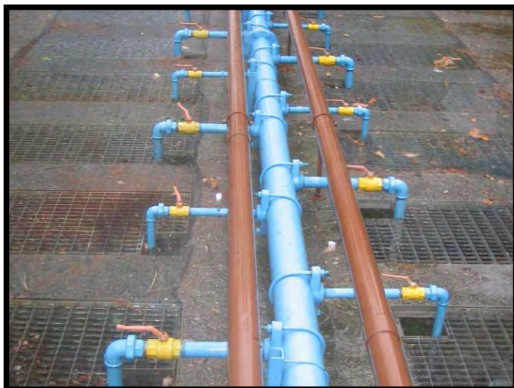
7 Sistema insufflazione aria ossidazione-nitrificazione
