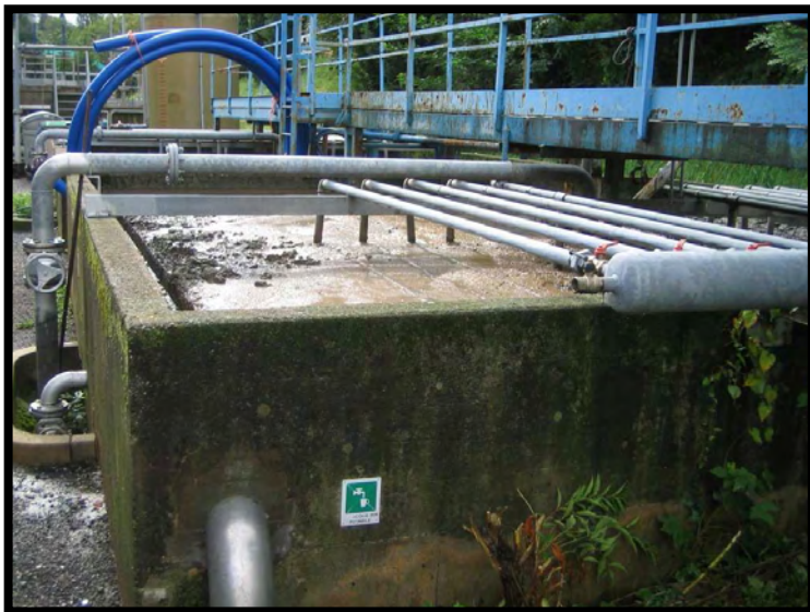
13 Digestione aerobica e ispessimento in batch
