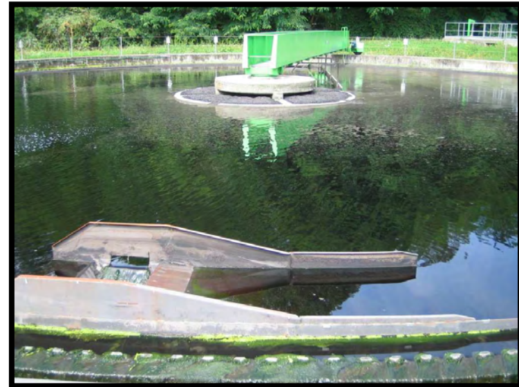
18 Sedimentazione secondaria
