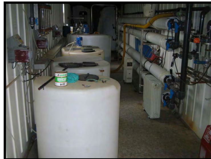
10 Impianto di denitrificazione di soccorso ad osmosi inversa
