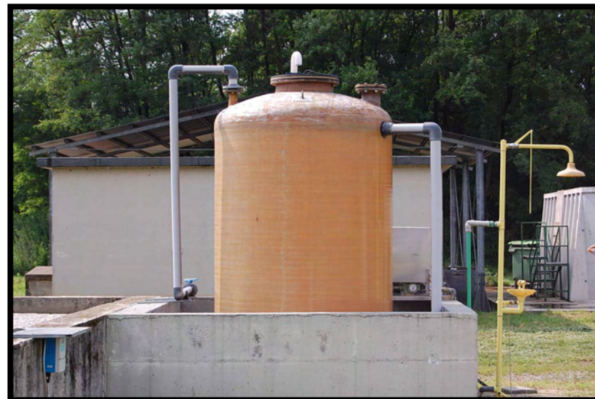
6 Defosfatazione chimica
