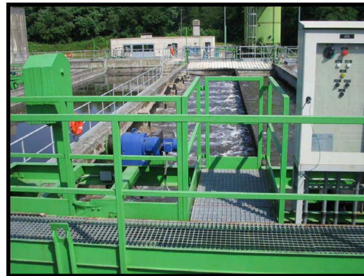
6 Dissabbiatura disoleatura
