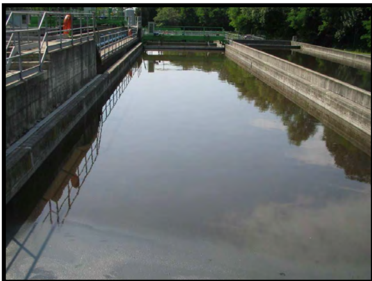
11 Sedimentazione primaria
