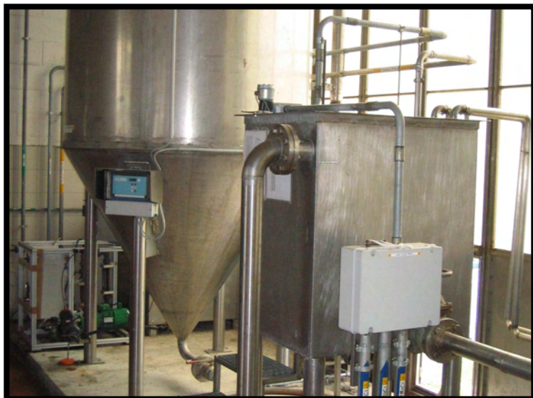
25 Stoccaggio polielettroliti in emulsione
