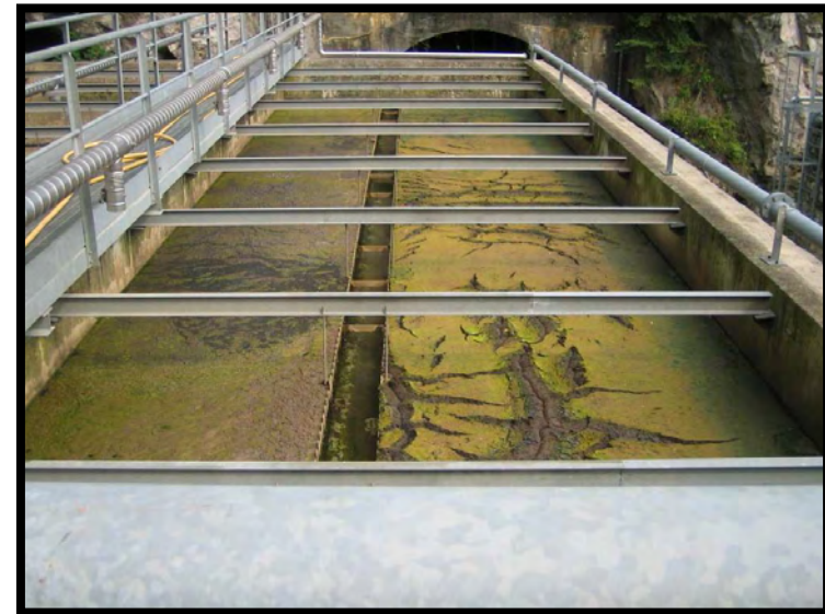
8 Sedimentazione secondaria
