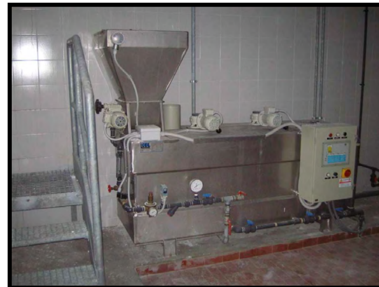
14 Preparazione polielettroliti
