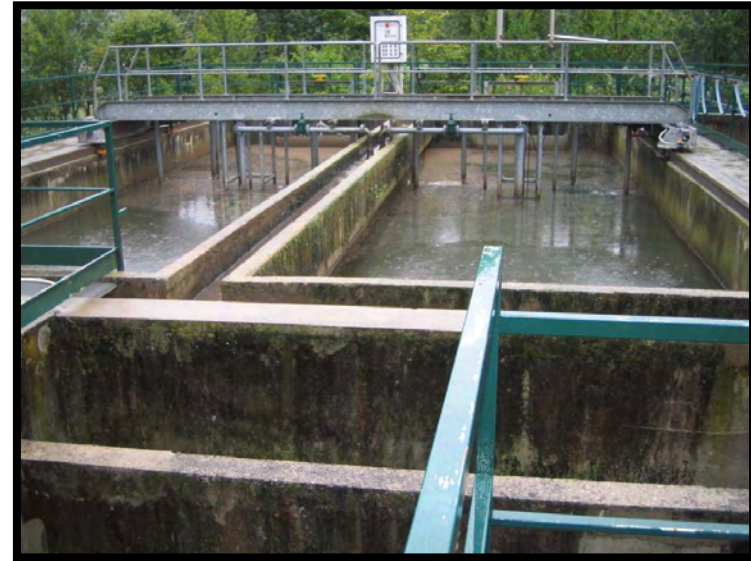
6 Sedimentazione secondaria
