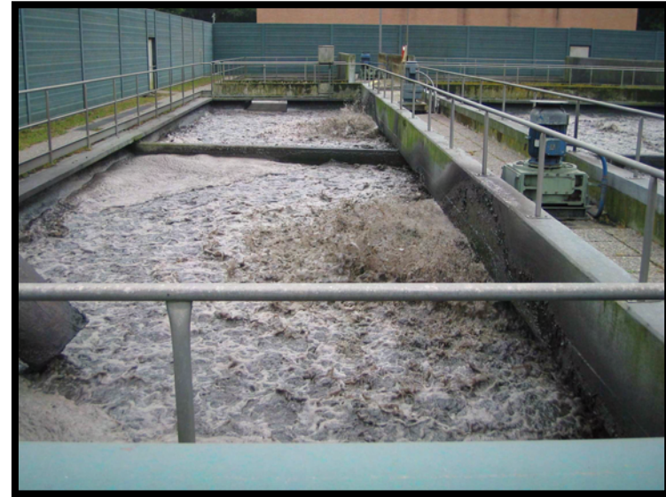
10 Ossidazione con turbina
