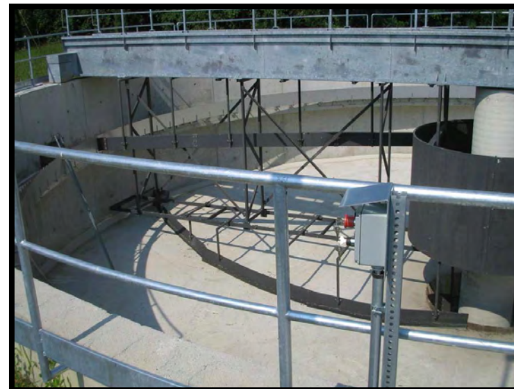
14 Sedimentazione secondaria nuova
