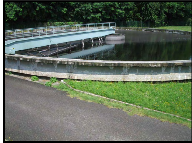
10 Sedimentazione secondaria
