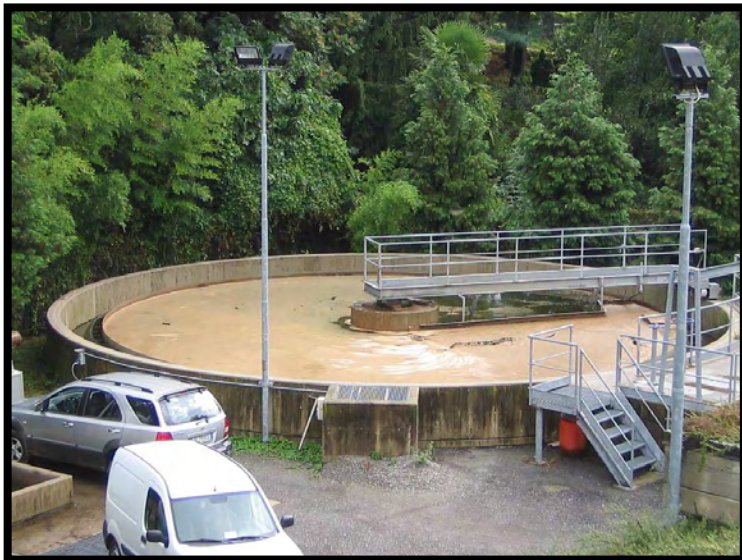
7 Sedimentazione secondaria
