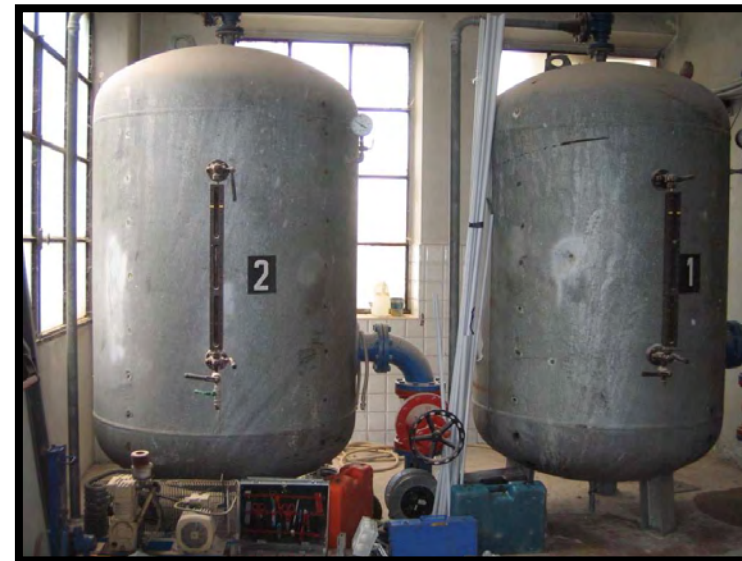
6 Serbatoi di espansione (anti colpo di ariete)
