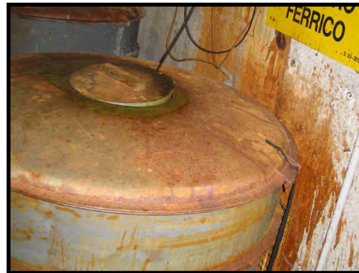
8 Serbatoio cloruro ferrico
