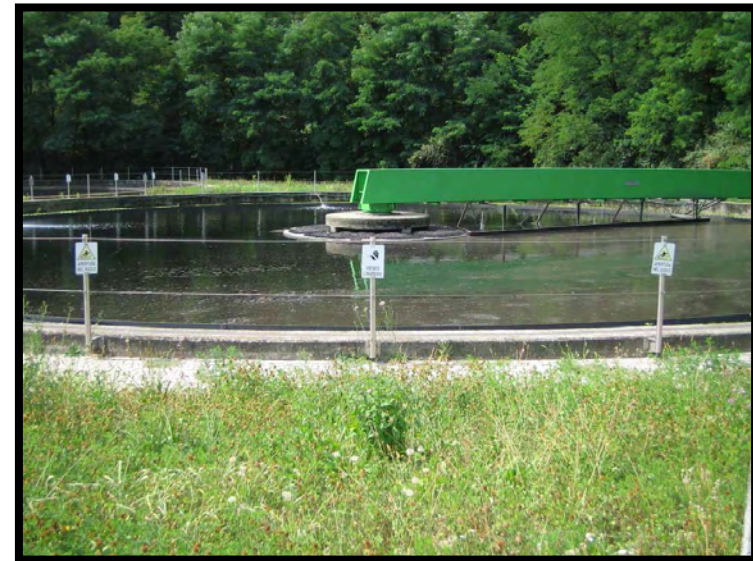
16 Sedimentazione secondaria
