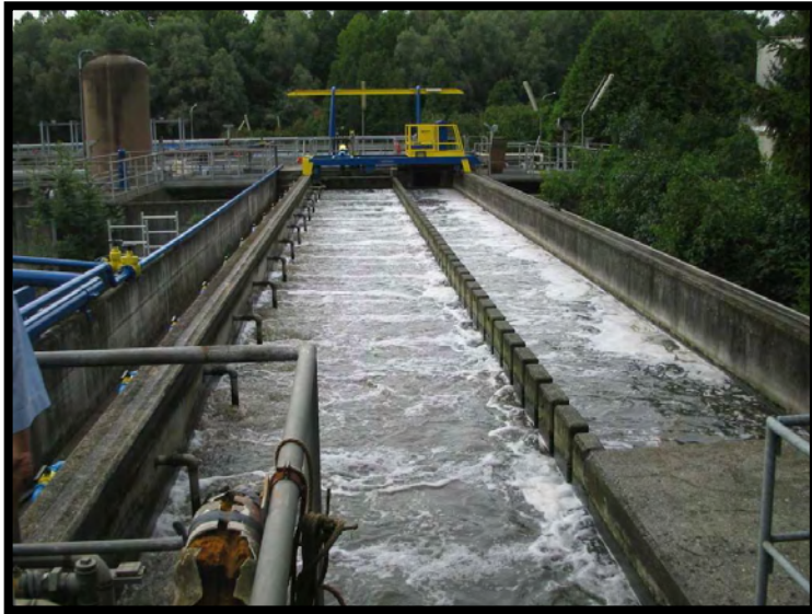
5 Dissabbiatura e disoleatura
