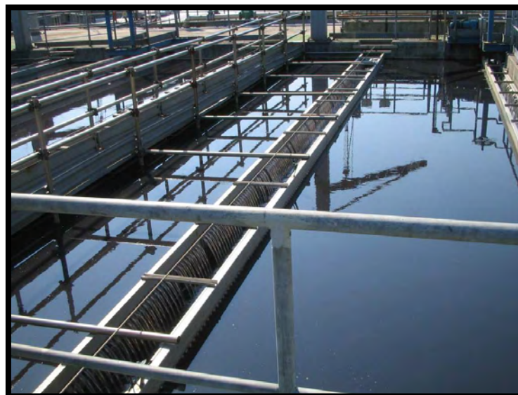
8 Sedimentazione a pacchi lamellari
