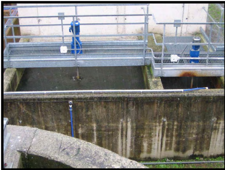
7 Coagulazione e flocculazione
