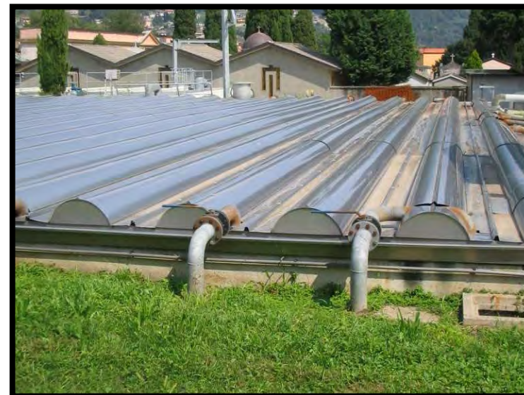
20 Digestione aerobica
