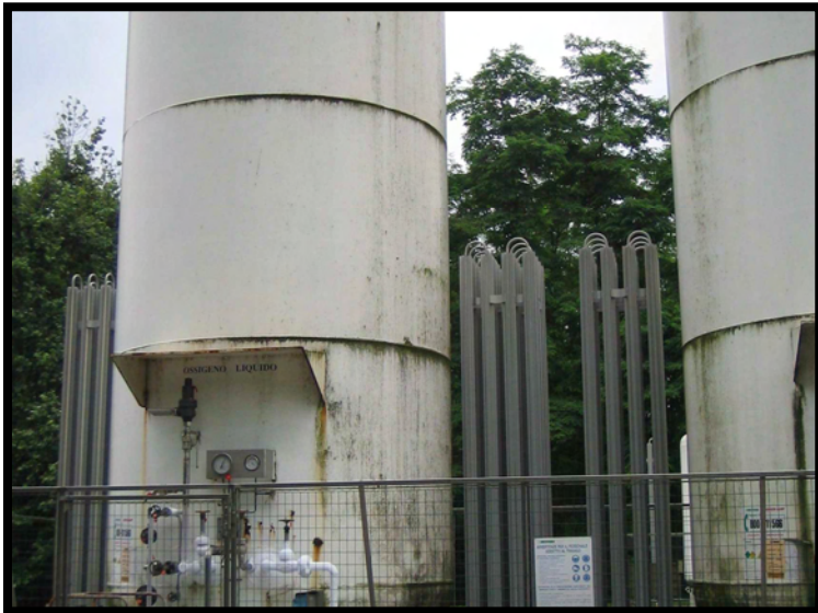
17 Serbatoi ossigeno liquido
