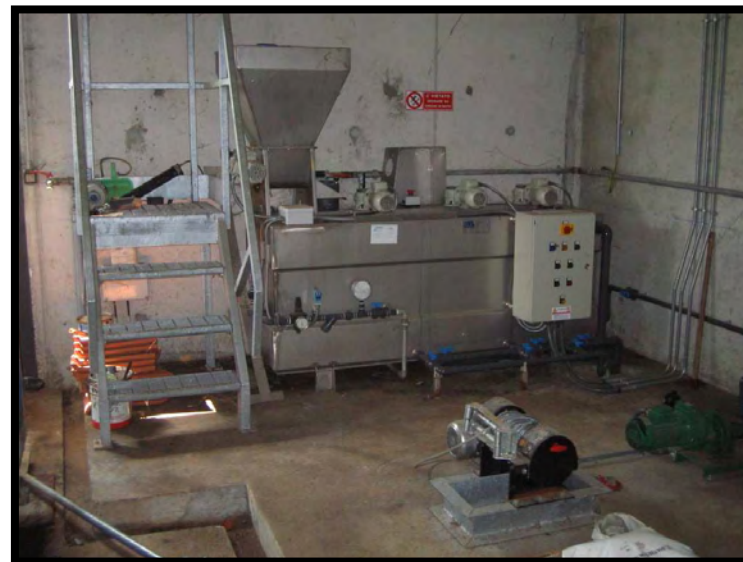
24 Preparazione polielettroliti
