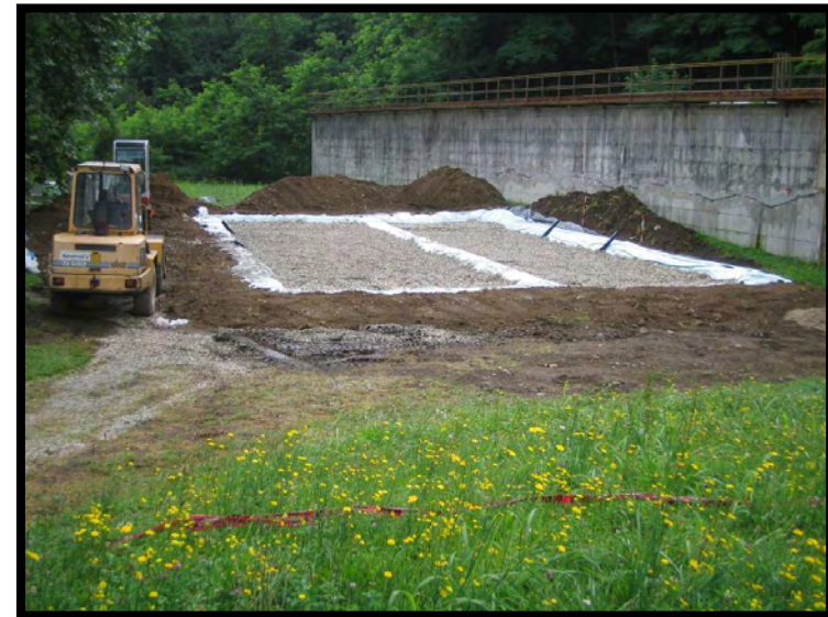
12 Realizzazione comparto di fitodepurazione
