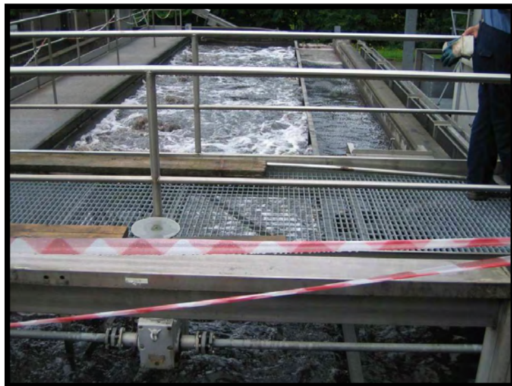
5 Dissabbiatura e disoleatura
