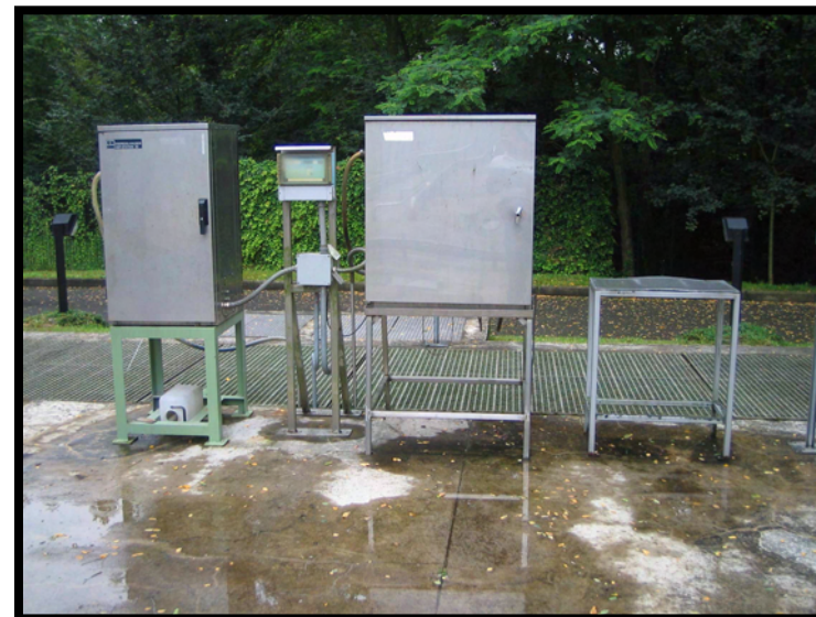
22 Campionatore automatico in uscita
