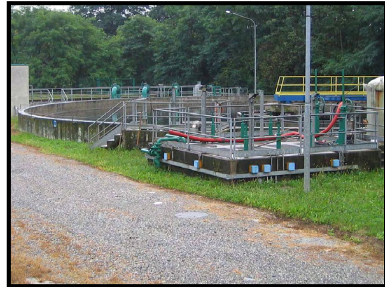
22 Sedimentazione secondaria
