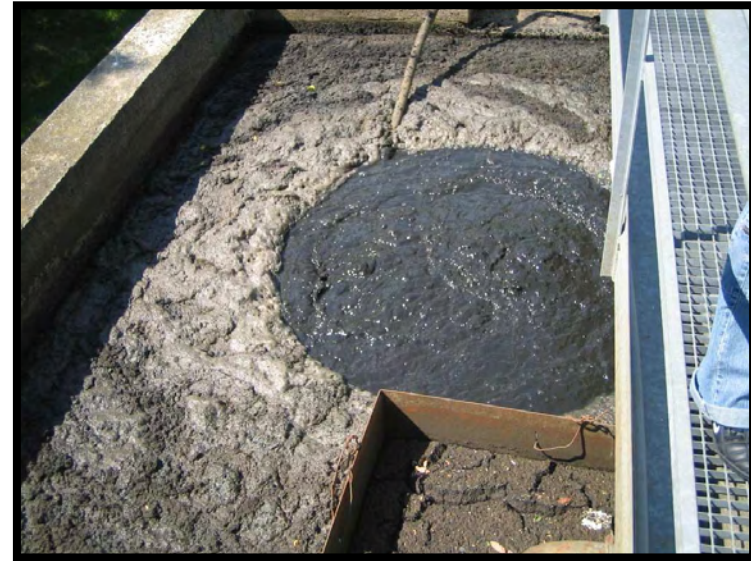
10 Digestione aerobica, ispessimento
