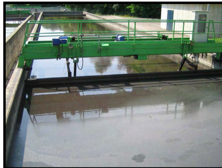
10 Sedimentazione primaria
