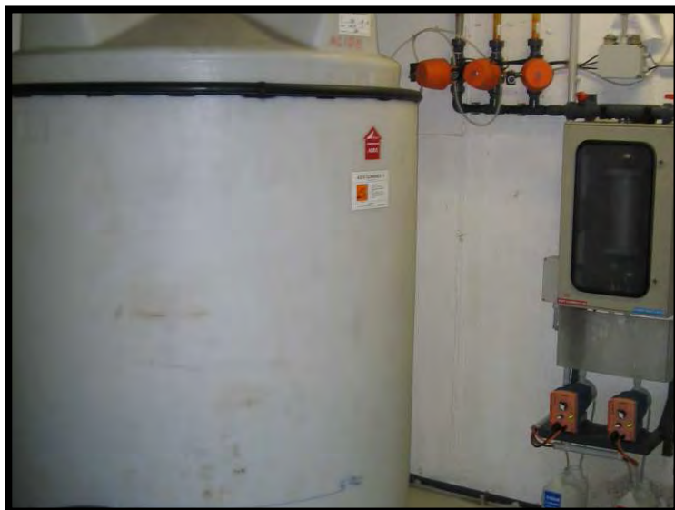
3 Sistema di dosaggio policloruro di Al
