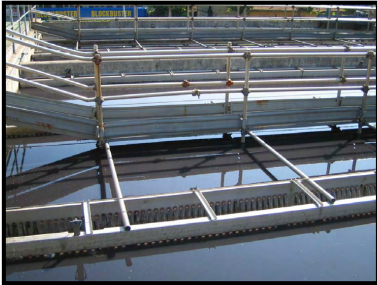
9 Sedimentazione a pacchi lamellari
